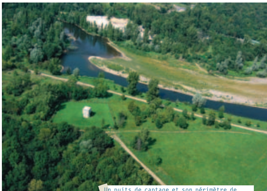
Un puits de captage et son périmètre de protection immédiat sur le site des Vaures
