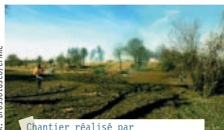
Chantier réalisé par l'Association de développement du Sullias sur la plaine de Vilaine à Ouzouer/Loire
