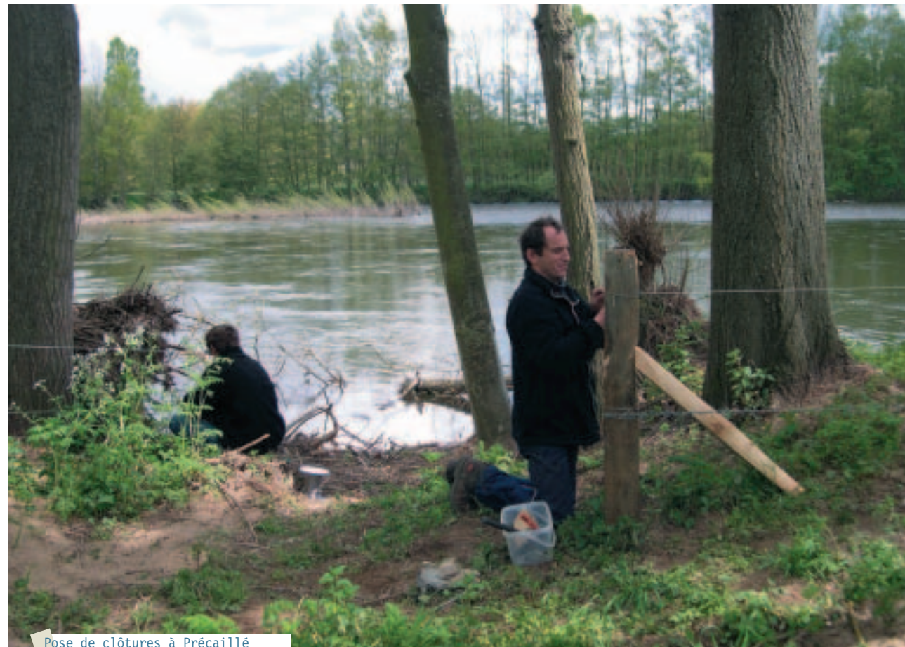
Pose de clôtures à Précaillé
