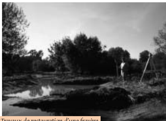
Travaux de restauration d'une frayère
